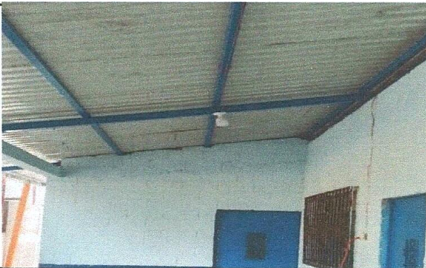
Foto 5: Pintado de paredes
