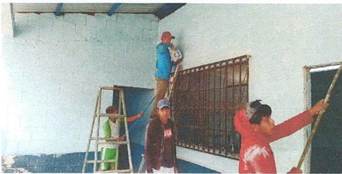
Foto 5: Pintado de paredes
