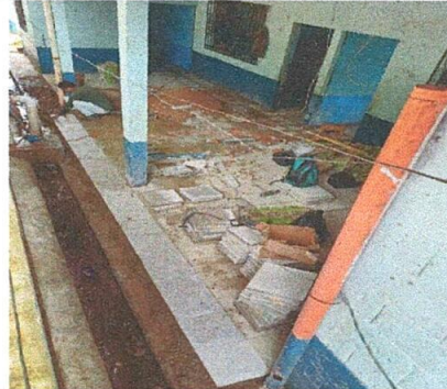
Foto 6: Sustitución de piso de torta de concreto por piso de granito
