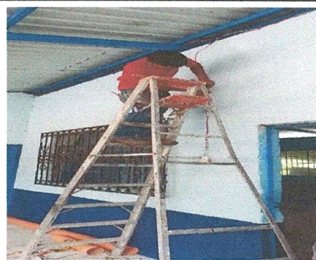
Foto 4: Reparación del cableado eléctrico
