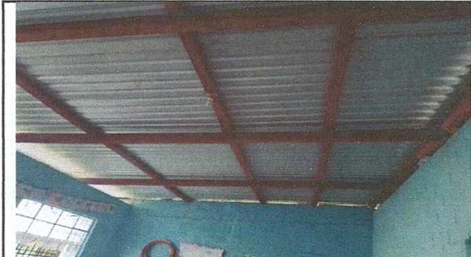
Foto 1: Sustitución de estructura de soporte de madera por metal
