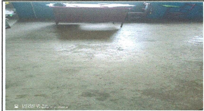
Foto 2: Sustitución de piso de torta de concreto por piso de granito
