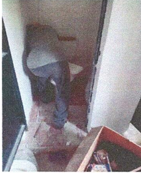
INSTALACION DE INODOROS
