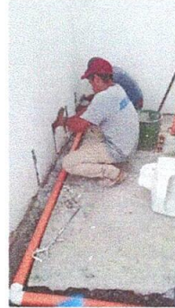
INSTALACION DE TUBERIA PARA MINGITORIO
