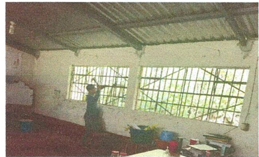
CAMBIO DE ESTRUCTURA DE VENTANAS
