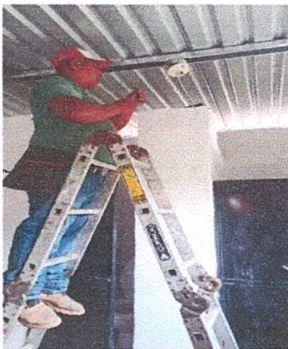
INSTALACION DE ENERGIA ELECTRICA
