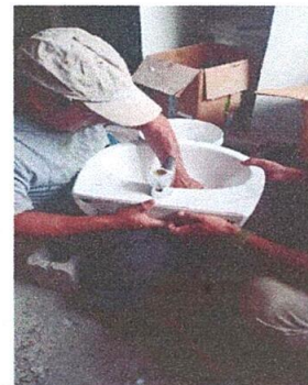
INSTALACION DE LAVAMANOS
