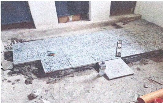
PEGADO DE PISO
