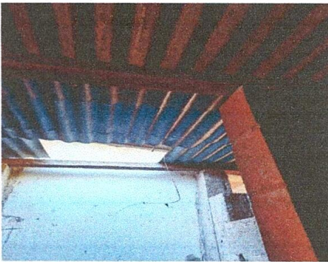
SUSTITUCION DE LAMINA POR LAMINA TROQUELADA
