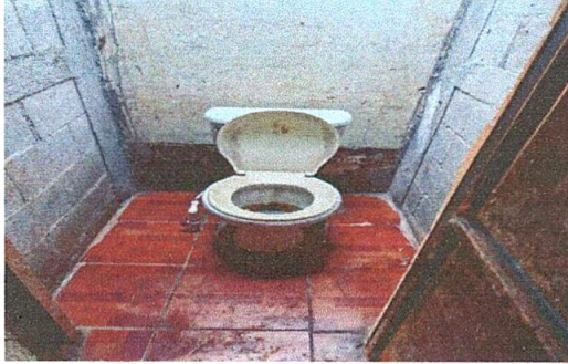
SUSTITUCION DE INODOROS
