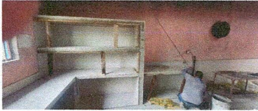
FOTO No.7 SUSTITUCIÓN DE ESTANTE DE CONCRETO
