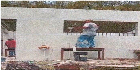
FOTO No, 5 MEJORAMIENTO DE PARED DE COCINA
