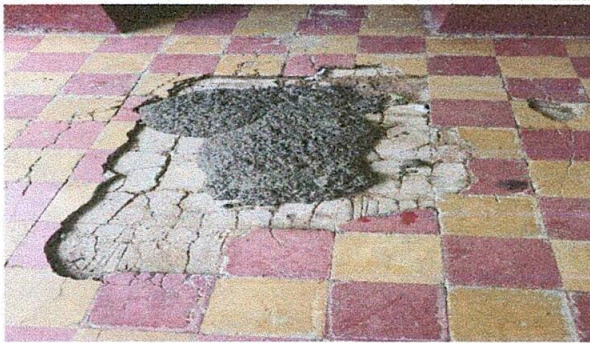
FOTO No. 3 REPARACIÓN DE PISO EN PASILLO, DIRECCIÓN Y AULAS
