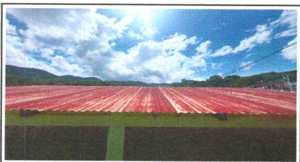
Foto 5: Sustitución de lámina, por lámina troqueladaaluzinc calibre 26
