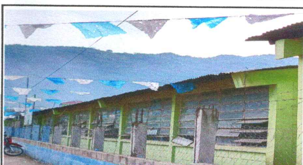
Foto 4: Sustitución de vidrios de ventanales y soldadura
