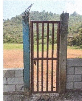
Foto 4. Sustitución de puerta de salida a la cancha de fútbol.
