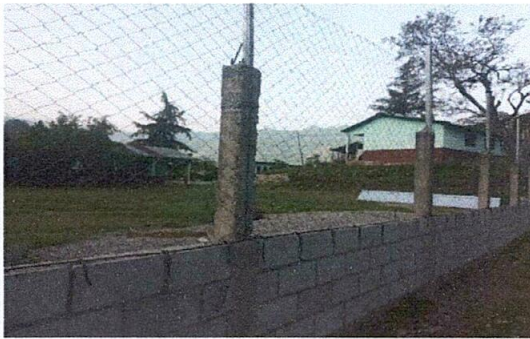
Foto 3. Reparación de muro perimetral con hiladas de block, tubos galvanizados y malla metálica.
