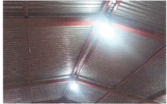
Foto 8. Sustitución de cableado eléctrico en aulas y corredor
