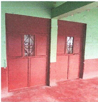
Foto 9. Manenimiento a 8 puertas de aulas y 1 de baño
