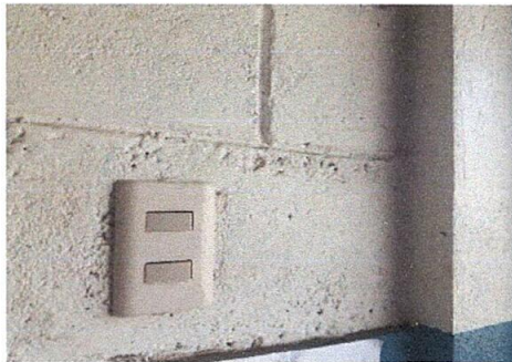
Foto 11. Sustitución de interruptores en aulas
