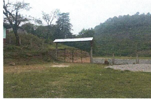
Foto 2. Sustitución y colocación de techo para los portones de entrada principal de la escuela y salida a la cancha de fútbol.
