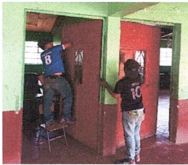
Foto 9. Manenimiento a 8 puertas de aulas y 1 de baño
