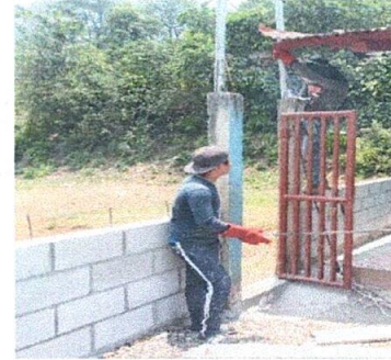
Foto 4. Sustitución de puerta de salida a la cancha de fútbol.
