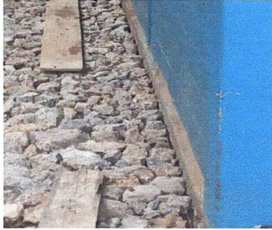
Foto 7. Construcción de cuneta de concreto para bajada de agua parte lateral de la escuela
