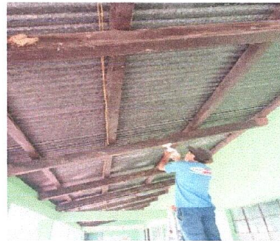
Foto 10. Sustitución de focos ahorradores en aulas y corredor
