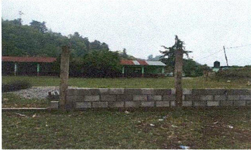
Foto 3. Reparación de muro perimetral con hiladas de block, tubos galvanizados y malla metálica.
