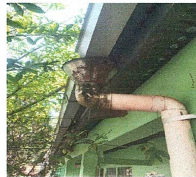
Foto 6. Sustitución de canaletas y caídas de agua.
