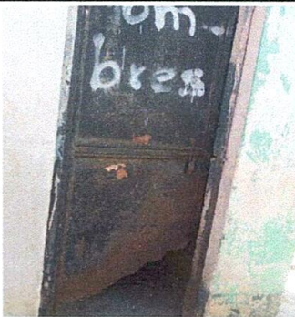
Foto 5. Sustitución de puertas de sanitarios.
