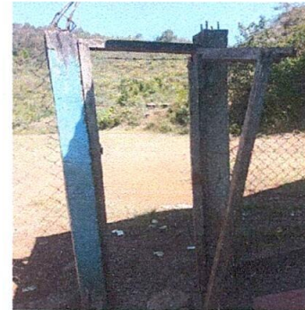
Foto 4. Sustitución de puerta de salida a la cancha de fútbol.
