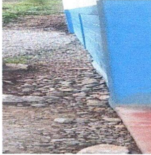
Foto 7. Construcción de cuneta de concreto para bajada de agua parte lateral de la escuela
