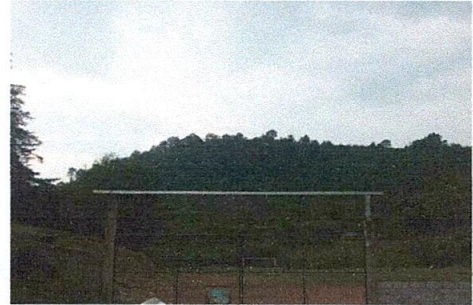
Foto 2. Sustitución y colocación de techo para los portones de entrada principal de la escuela y salida a la cancha de fútbol.
