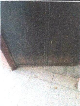
Foto 3: Mantenimiento a estructura de metal(puerta) lijado y aplicación de pintura.
