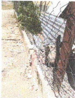
Foto 1; Levantamiento de muro perimetral para evitar que entre corrientes de agua en temporada de lluvia y cambio de malla.
