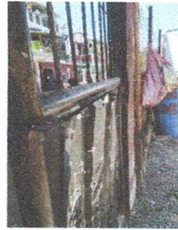
Foto 2: mantenimiento de porton de entrada principal a la escuela.
