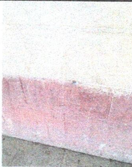
Foto 5: Pintura de muros (paredes) exteriores e interiores.
