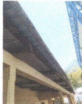
Foto 4: Sustitución de bajada de agua pluvial PVC.
