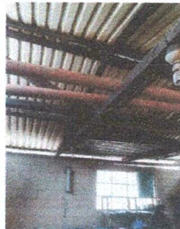
Foto 6 : Sustitución de estructura de soporte de madera por metal para techo de cocina.
