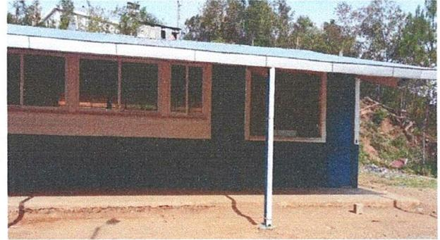
Foto 8 : Instalación de canalón lámina aluzinc.
