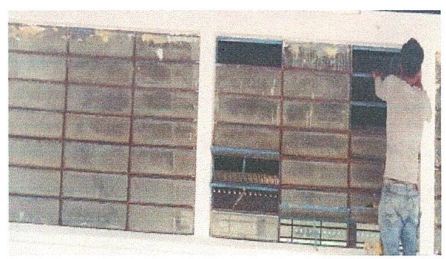
Foto 4: Sustitución de ventanas
