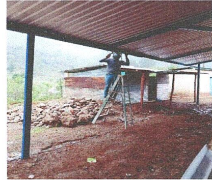
Foto 8: Instalación de canalón lámina aluzinc.
