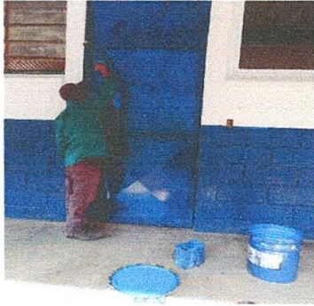
Foto 7: Mantenimiento a puerta estructura de metal
