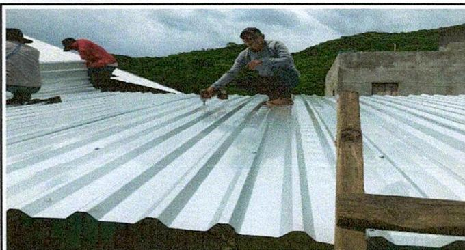
Foto 5: Sustitución de lámina, por lámina troquelada aluzinc calibre 26 de techo de cocina y sustitución de capote.
