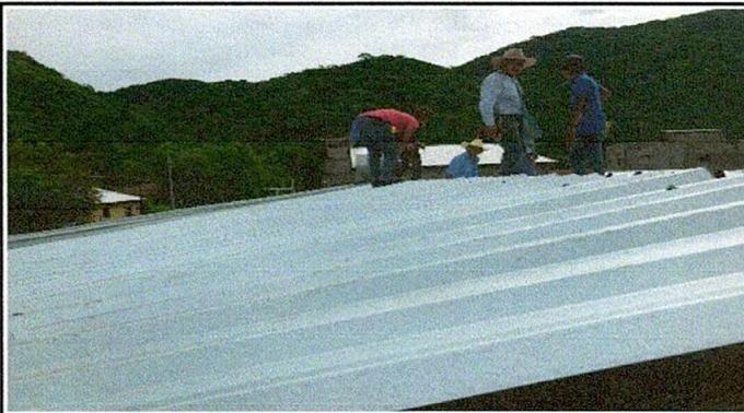
Foto 3: Sustitución de lamina, por lámina troquelada aluzinc calibre 26. aula de quinto y sexto grado. Sustitución de capote.
