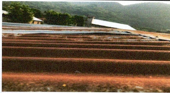
Foto 3: Sustitución de lámina, por lámina troquelada aluzinc calibre 26. aula de quinto y sexto grado. Sustitución de capote.
