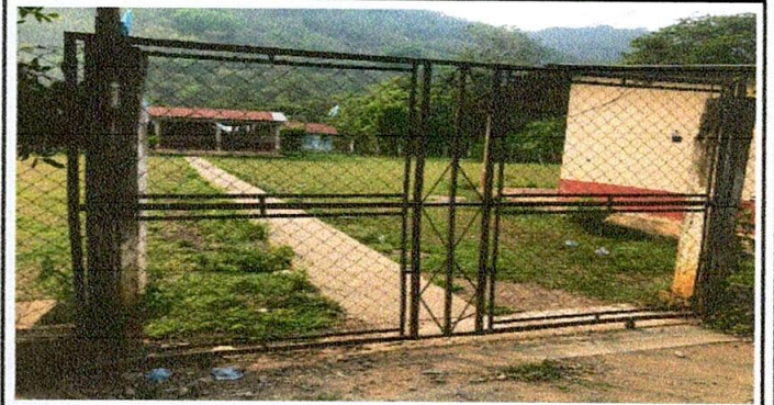
Foto 4: Sustitución de portón
