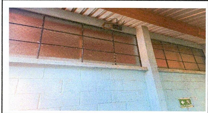
Foto 7. sustitucion de estructura de metal de ventanas.
