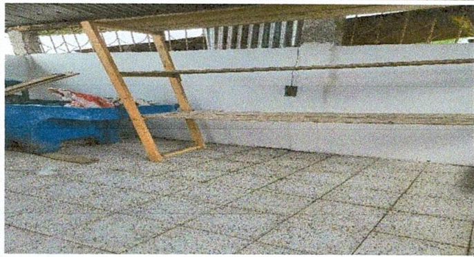
Foto 1. Repello de muro interior y exterior en cocina
