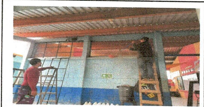
Foto 7. sustitucion de estructura de metal de ventanas.
