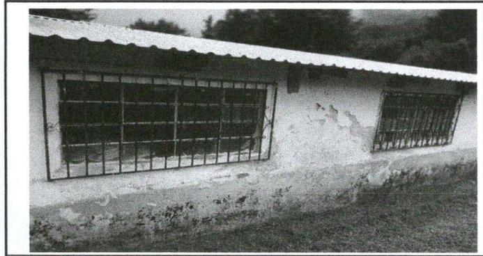
Foto 6: La pintura en paredes exteriores esta deteriorada.
