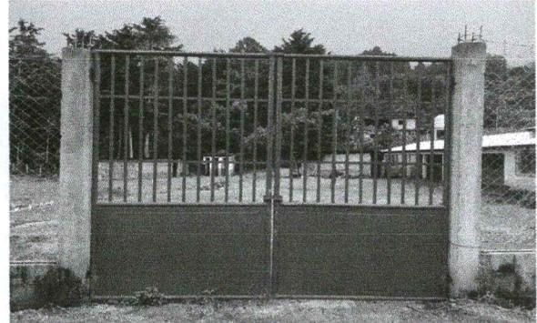
Foto 2: El portón necesita protección por estar a la intemperie, expuesto a los rayos del sol y lluvias.
