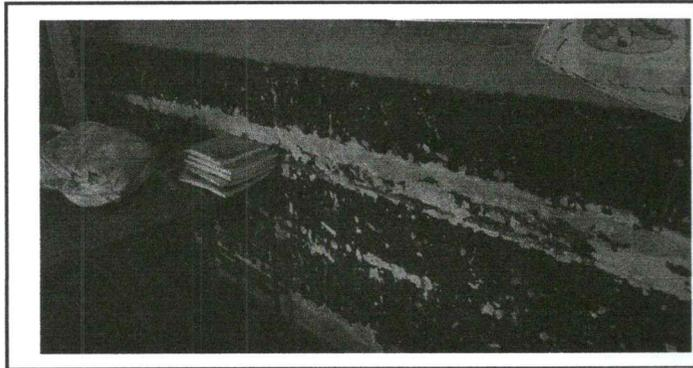
Foto 5: La pintura en paredes interiores esta deteriorada.
