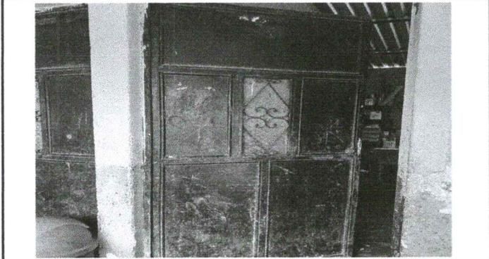
Foto1: Las puertas de metal se encuentran corroidas.
