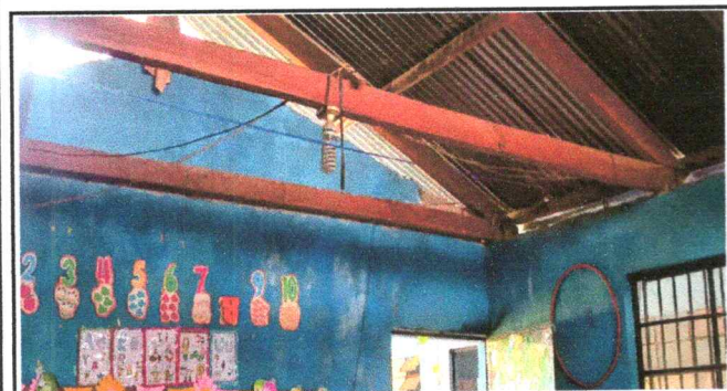
Foto 9: Reparación de sistema eléctrico.
