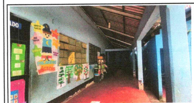
Foto 3: Pintura en muros exteriores e interiores
