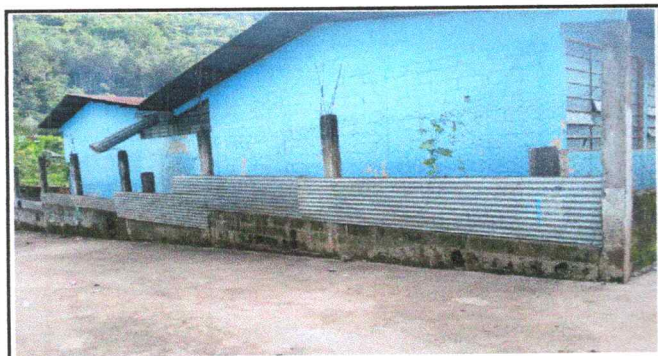
Foto 7: Muros perimetrales (circulación del edificio escolar)
