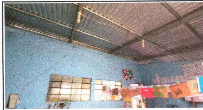
Foto 10: Reparación de sistema eléctrico.
