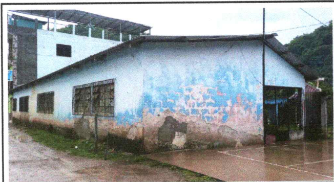
Foto 13: Reparación de repello en paredes.
