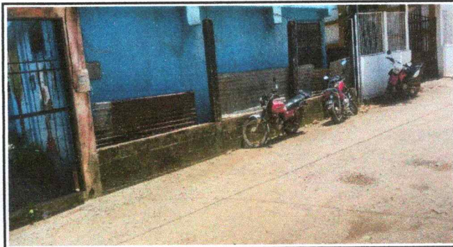
Foto 8: Muros perimetrales (circulación del edificio escolar)
