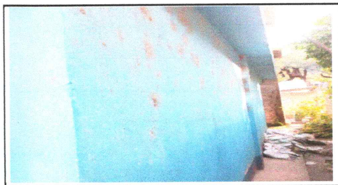
Foto 4: Pintura en muros exteriores e interiores
