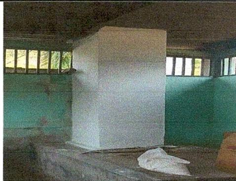
Foto 2: Sustitución de chimenea de concreto.
