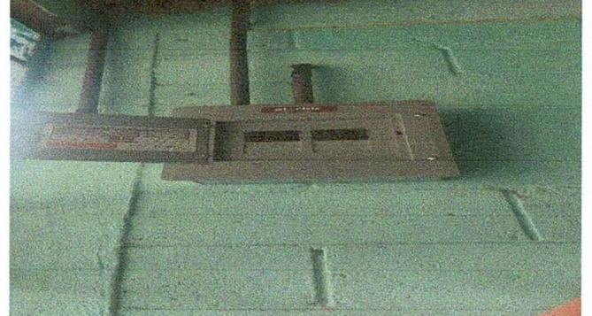
Foto 10: Sustitución de tablero de flipón.
