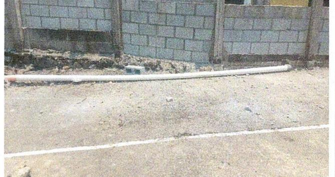
Foto 12: Sustitución de tubería PVC línea principal de aguas negras.
