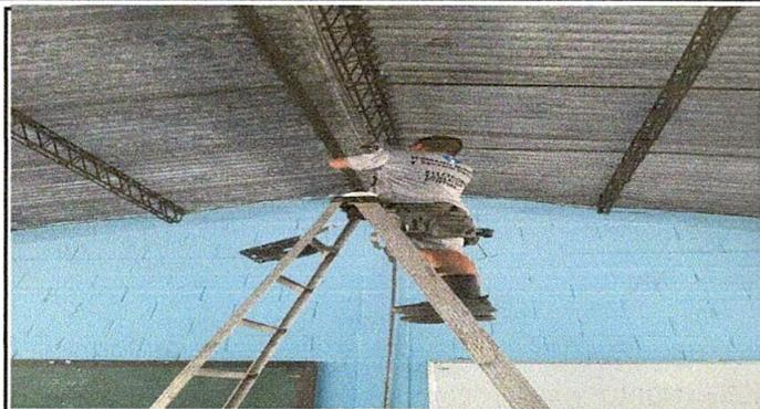
Foto 7: Sustitución de lámparas tipo led.
