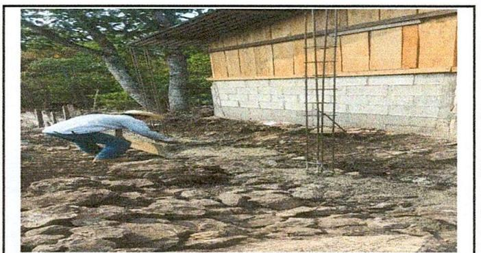
Foto 6: Reparación de muro perimetral con block, malla galvanizada, soleras intermedias y columna de concreto.
