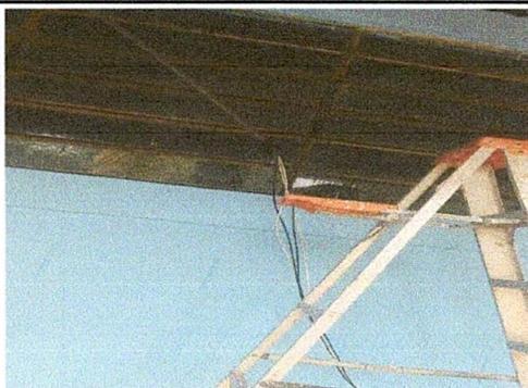
Foto 11: Sustitución de cableado eléctrico
