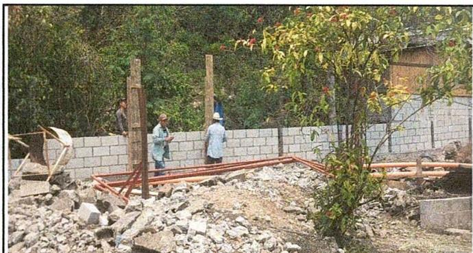
Foto 5: Reparación de muro perimetral con block, malla galvanizada, soleras intermedias y columna de concreto.
