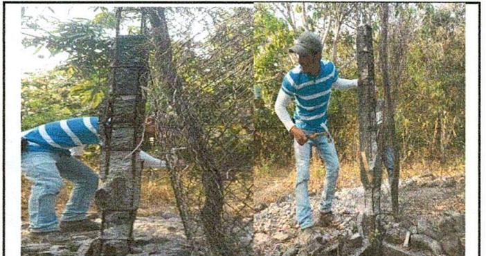
Foto 4: Reparación de muro perimetral con block, malla galvanizada, soleras intermedia y columna de concreto.
