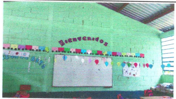
Foto 4: Pintura de muros interiores y exteriores
