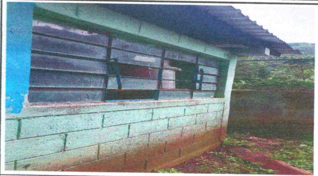
Foto 2: Sustitución de ventana
