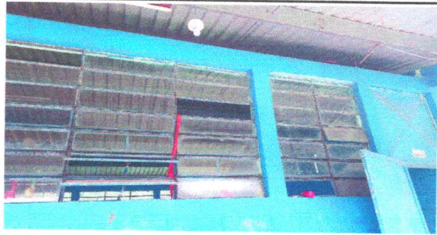
Foto1: Sustitución de ventana
