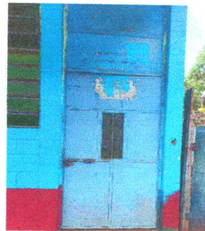
Foto 6: aplicación de pintura
