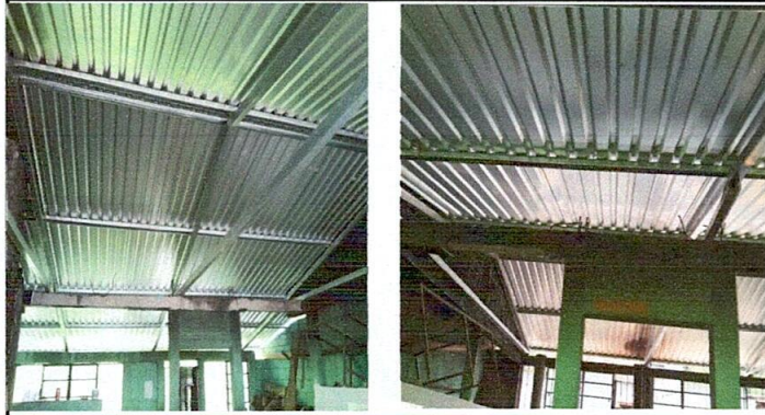
CUBIERTA DE LÁMINA
