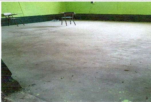
REPARACION DE PISO
