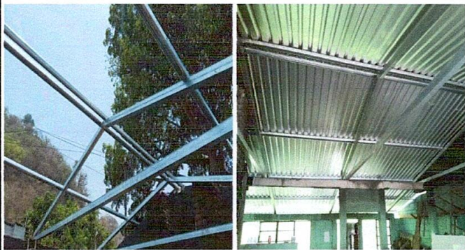
ESTRUCTURA DE TECHO
