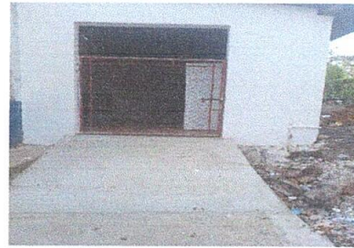
Foto 8: Repello en muros y mejoramiento de acceso a sanitarios
