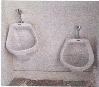
Foto 7: Sustitucion de mingitorios
