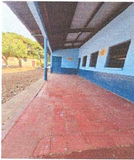
Foto 9: Reparacion de de piso de torta de concreto
