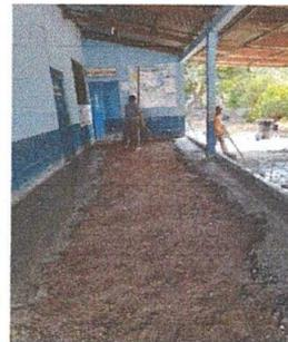
Foto 4: sustitucion de piso de cemento por piso ceramico en el corredor y direccion.
