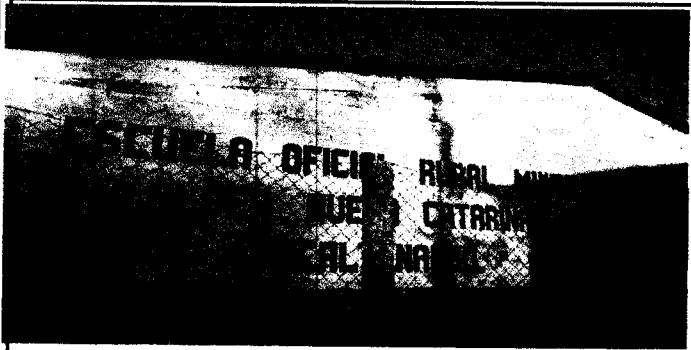
Foto 1: Pared de las aulas que se pintarán en el interior y exterior.
