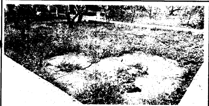
Foto 3: Esta es la plancha de concreto del patio que se quiere reparar
