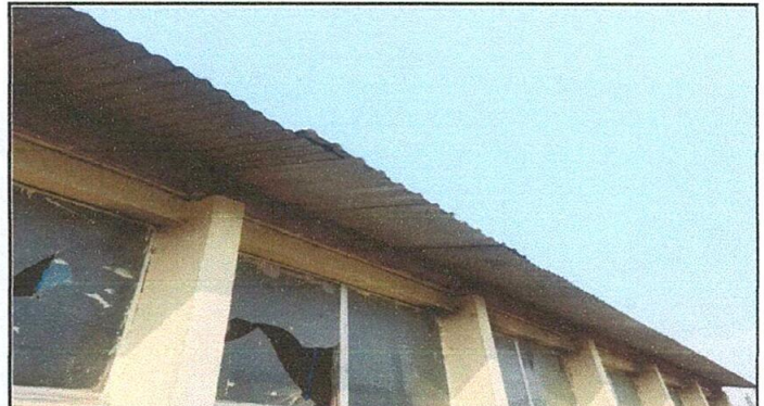
Foto 2: Para una mejor observación, puede apreciarse la colocación de las láminas en el aula que da frente a la calle de la entrada principal de la escuela.
