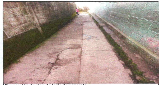
Reparación de piso de torta de concreto
