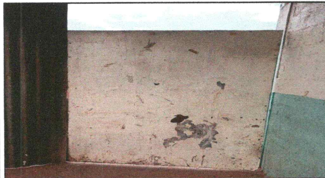
Sustitución de portón de metal
