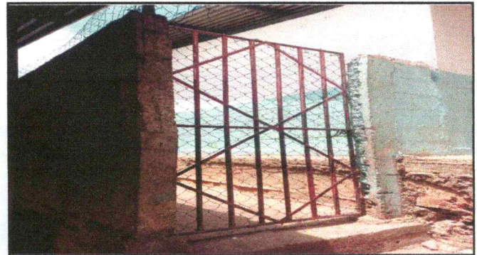
Sustitución de portón de metal
