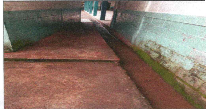
Reparación de piso de torta de concreto
