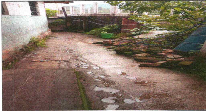
Reparación de piso de torta de concreto
