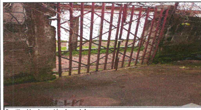
Sustitución de portón de metal
