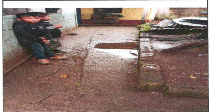
Reparación de piso de torta de concreto
