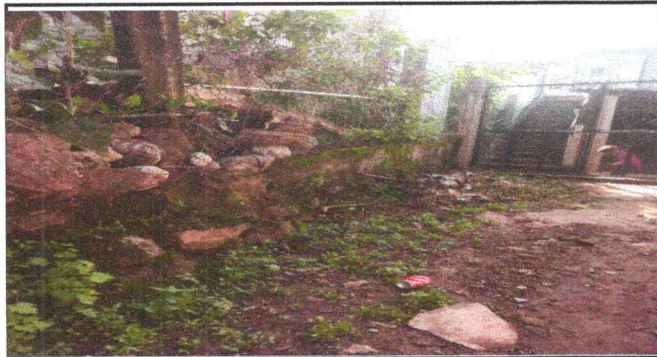
Reparación de muro perimetral de block
