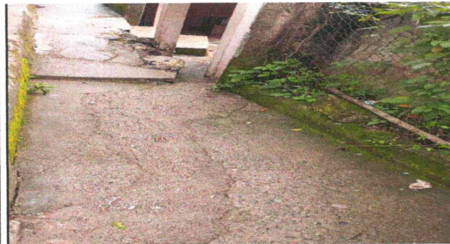
Reparación de piso de torta de concreto
