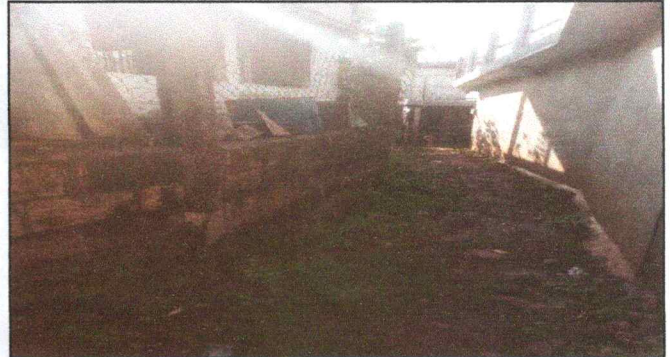
Reparación de muro perimetral de block
