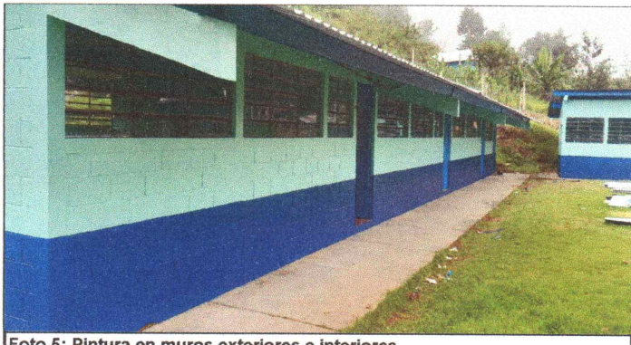
Foto 5: Pintura en muros exteriores e interiores
