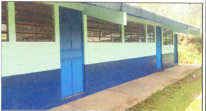
Foto 4: Mantenimiento a puertas (lijado y aplicación de pintura)
