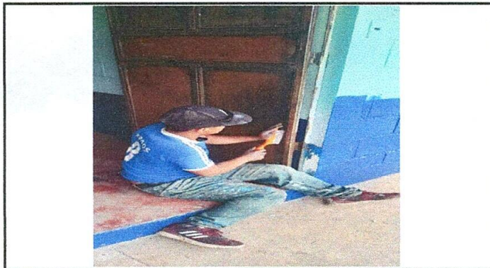
Foto 3: Mantenimiento a puertas (lijado y aplicación de pintura)
