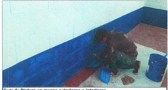
Foto 6: Pintura en muros exteriores e interiores
