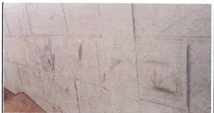
Foto 6: Pintura en muros exteriores e interiores
