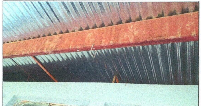
Foto 2: Mantenimiento a estructura de soporte de metal
