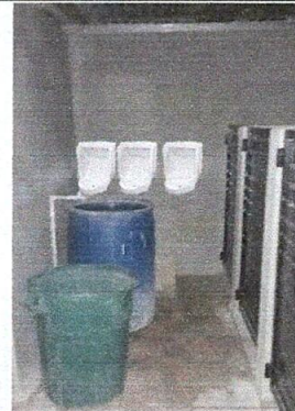
Foto 4: Instalación de los mingitorios
