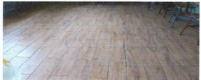
Foto 6: piso de aulas terminado
