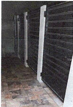
Foto 3: Puertas instaladas de los servicios sanitarios
