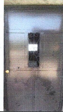
Foto 2: Puerta instalada en la cocina
