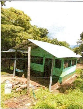
Foto 5: Sustitución de lamina troquelada calibre 26
