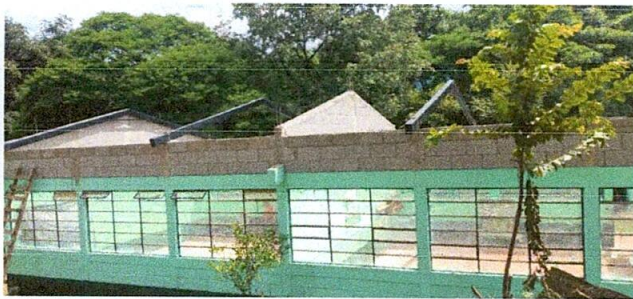
Foto 3: Sustitución de lamina troquelada calibre 26
