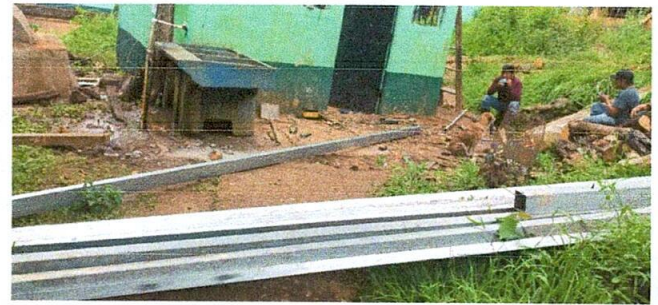
Foto 4: Soldadura de estructura de metal
