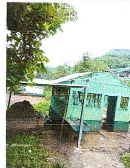
Foto 6: Sustitución de lamina troquelada calibre 26
