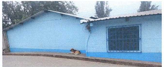
Foto 16: Pintura en exteriores
