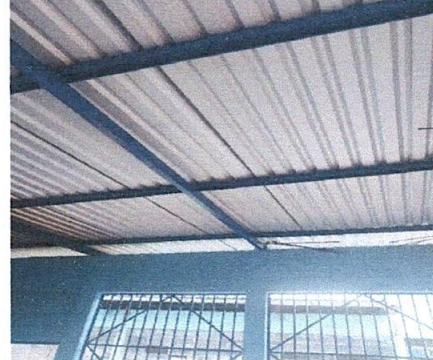
Foto 2: Sustrucción de lamina y estructura de soporte de madera por metal del area de cocina
