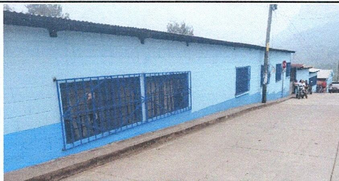
Foto 17: Pintura en exteriores
