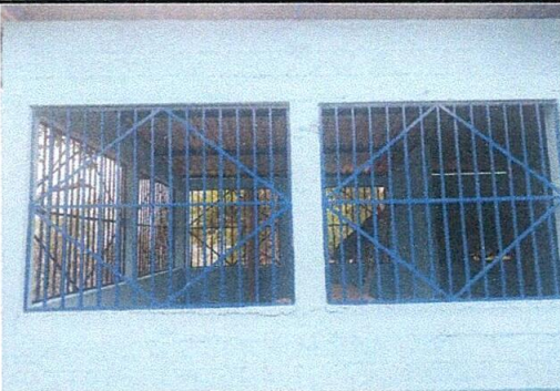
Foto 5: Sustrucción de malla en ventanas por balcon de metal
