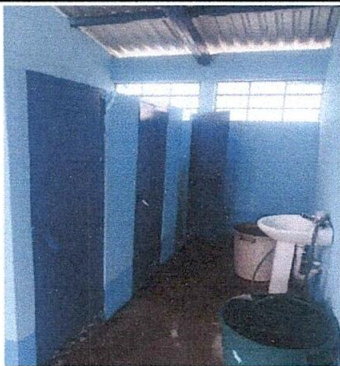
Foto 9: Sustitución de 3 puertas de madera del baño por metal y sustitución de un lavamanos.
