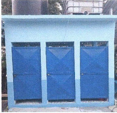
Foto7: Mantenimiento de 3 puertas de metal de baños
