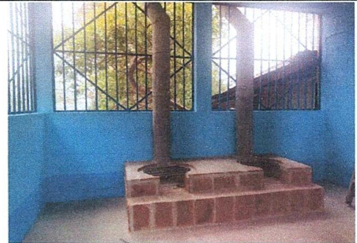
Foto 4: Sustrucción de estufa rural y reparación de piso en la cocina
