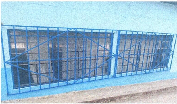
Foto 15: mejoramiento de Balcones y pintura en exteriores
