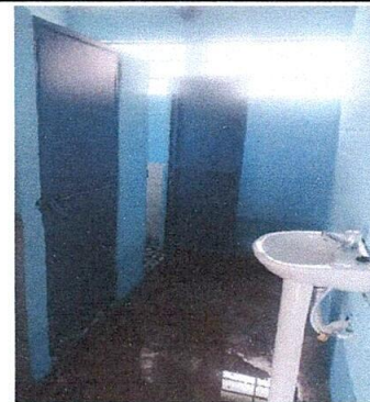
Foto 10: Sustitución de 2 puertas de madera por metal y sustitución de un lavamanos.
