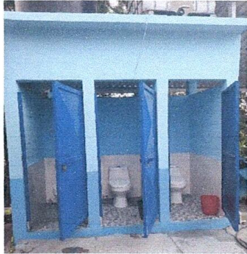
Foto 16: Mejoramiento de Baños con azulejos, cambio de accesorios y sustitución de taza.
