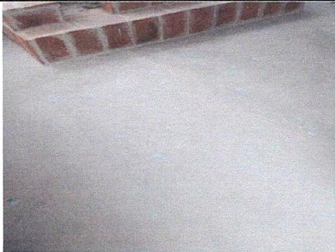
Foto 3: Reparación de piso de torta de cemento en la cocina
