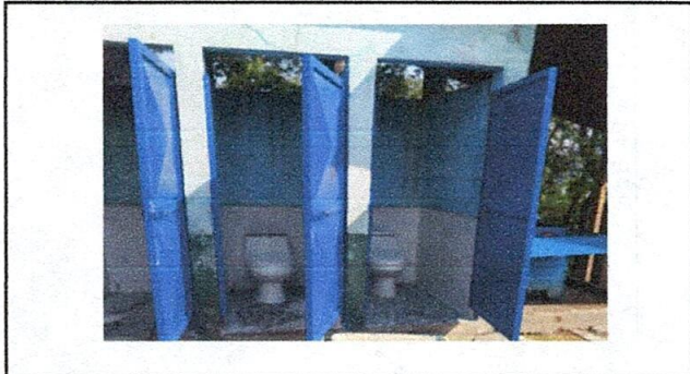
Foto 7: Mantenimiento de 3 puertas de metal de baños
