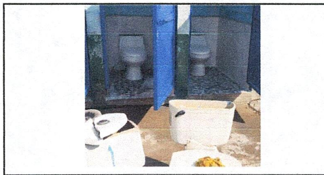
Foto 12: Cambio de accesorios y tapa de taza
