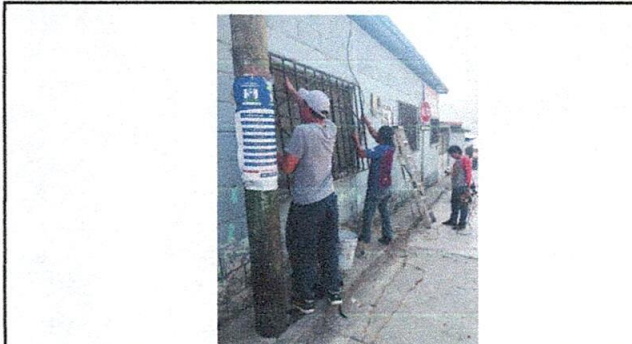
Foto 14: Mejoramiento de Balcones y Cambio de vidrios
