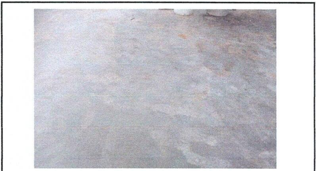
Foto 4: Reparación de piso de torta de cemento en la cocina
