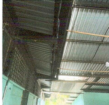
Foto 2: SUSTITUCIÓN DE CANAL DE METAL Y CAÍDA DE AGUA
