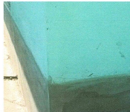
Foto 6: MANTENIMIENTO Y REPARACIÓN DE PARED
