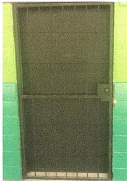
Foto 3: MANTENIMIENTO DE PUERTAS DEL ÁREA DE COMPUTACIÓN
