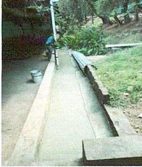
Foto 1: MANTENIMIENTO Y REPARACIÓN DE CUNETETA DE CONCRETO
