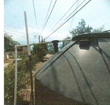
Foto 2: CAMBIO DE VÁLVULA
