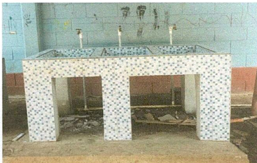
Foto 5: MANTENIMIENTO Y REPARACIÓN DE PILETA
