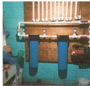
Foto 6: MANTENIMIENTO FILTROS AGUA PURIFICADA
