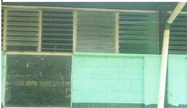
Foto 3: SUTITUCIÓN DE VIDRIOS QUEBRADOS
