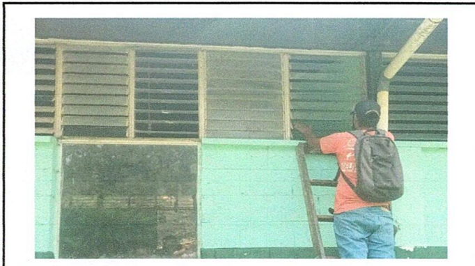
Foto 3: SUSTITUCIÓN DE VIDRIOS
