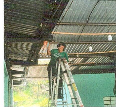
Foto 2: SOLDADURA DE CANAL DE METAL Y CAÍDA DE AGUA
