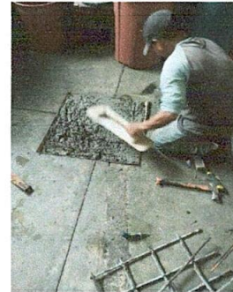
Foto 4: MANTENIMIENTO DE DRENAJE
