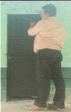
Foto 5: MANTENIMIENTO DE PUERTAS DE BAÑOS
