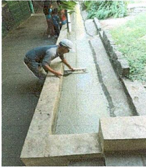
Foto1: MANTENIMIENTO DE CUNETETA DE CONCRETO
