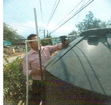
Foto 2: CAMBIO DE VÁLVULAS
