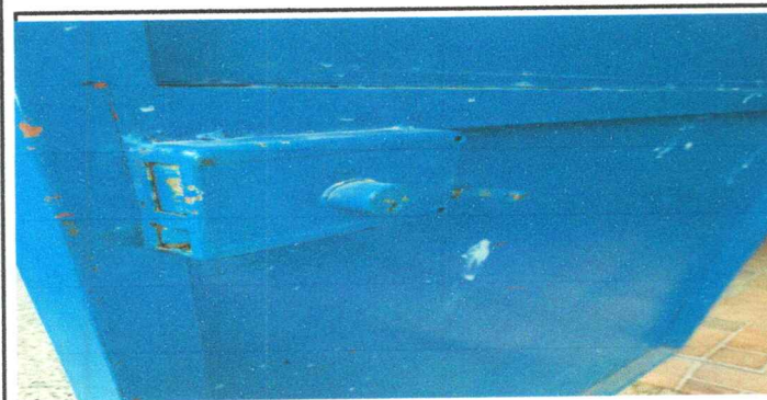
Foto 11: Sustitución de chapa
