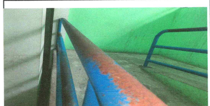
Foto 6: Mantenimiento a barandas de metal
