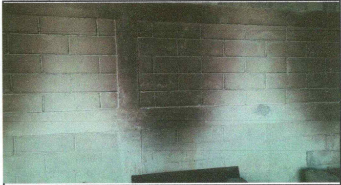
Foto 16: Repello en muro deteriorado
