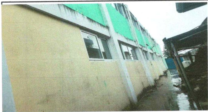
Foto1: Aplicación de pintura en partes deterioradas.
