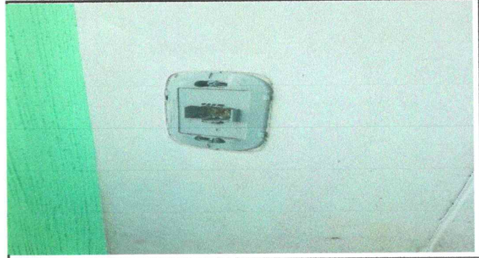
Foto 8: Sustitución de interruptores simples.
