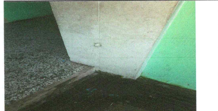
Foto 10: Sustitución de llave de chorro
