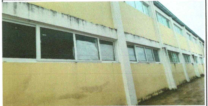
Foto 2: Aplicación de pintura en partes deterioradas.
