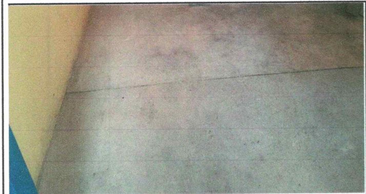
Foto 15: Sustrucción de piso de torta de concreto por piso de granito en cocina 2.
