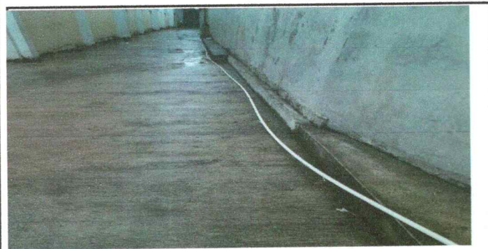
Foto 9: Sustitución de tubería lineal principal
