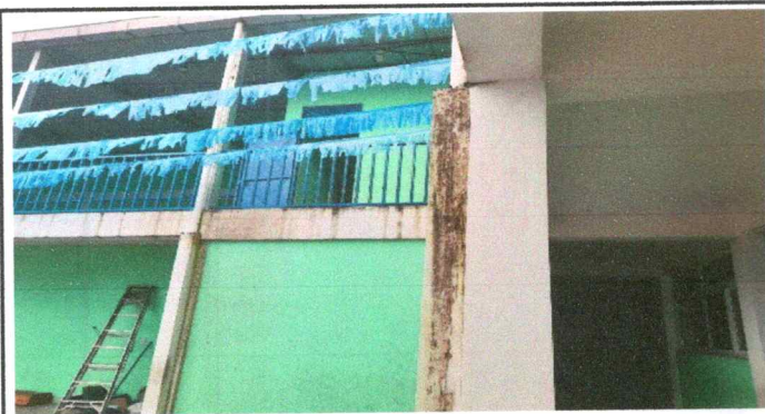
Foto 3: Aplicación de pintura en columnas deterioradas
