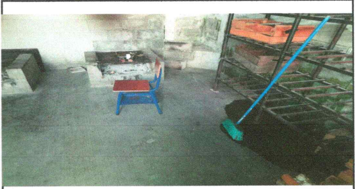
Foto 14: Sustrucción de piso de torta de concreto por piso de granito en cocina 1.
