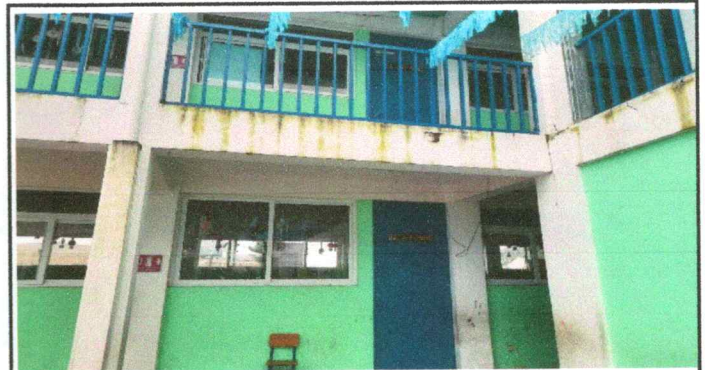
Foto 4: Aplicación de pintura en columnas deterioradas
