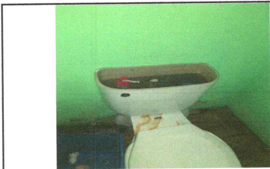
Foto 5: Sustitución de accesorios de inodoros
