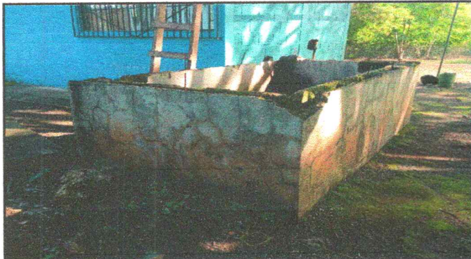
Foto 15: Reparación de sisterna de concreto
