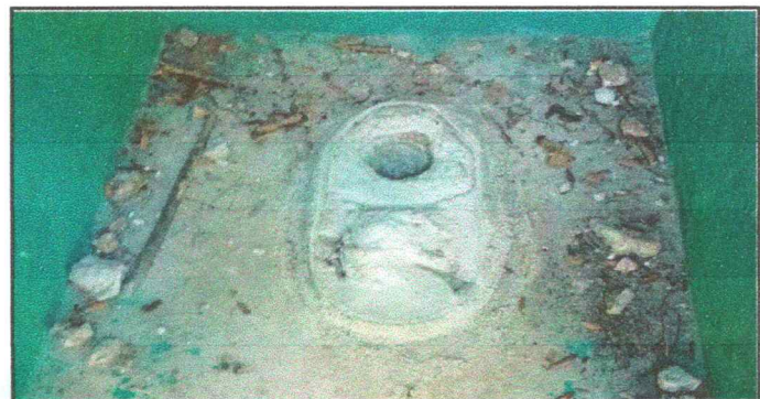
Foto 12: Sustitución de inodoro
