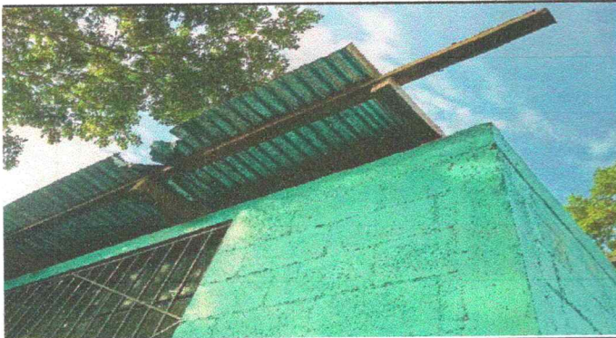
Foto 3: Sustitución de lámina
