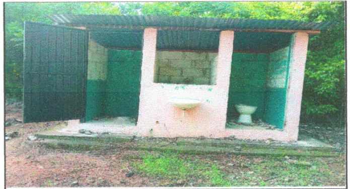
Foto 14: Sustitución de lavamanos
