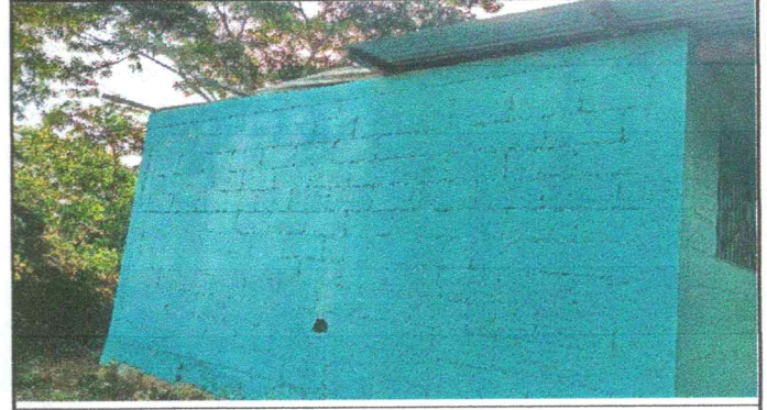
Foto 4: Sustitución de lámina
