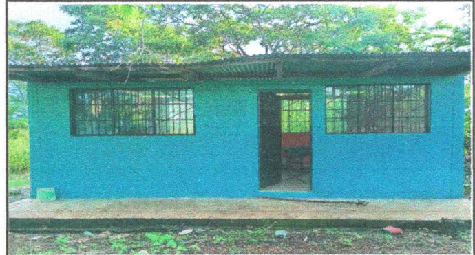
Foto 10: Levantamiento de aula
