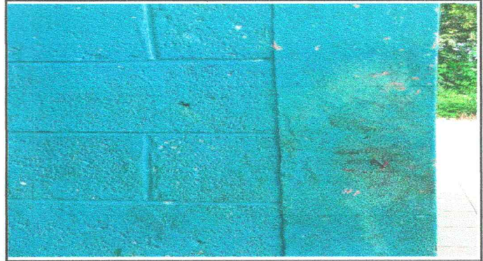
Foto 8: Pintura de muros
