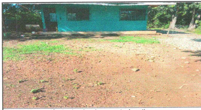
Foto 17: Reparación de planchas de concreto de patio
