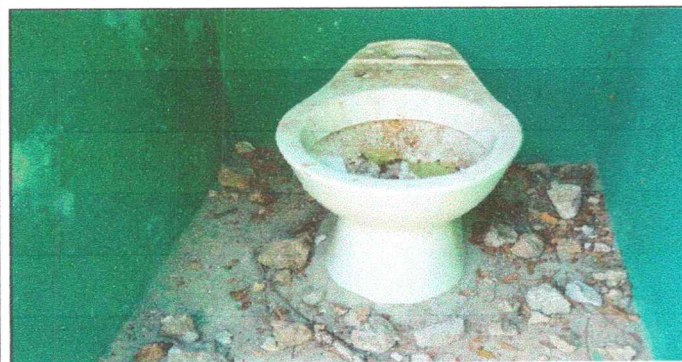
Foto 11: Sustitución de inodoro
