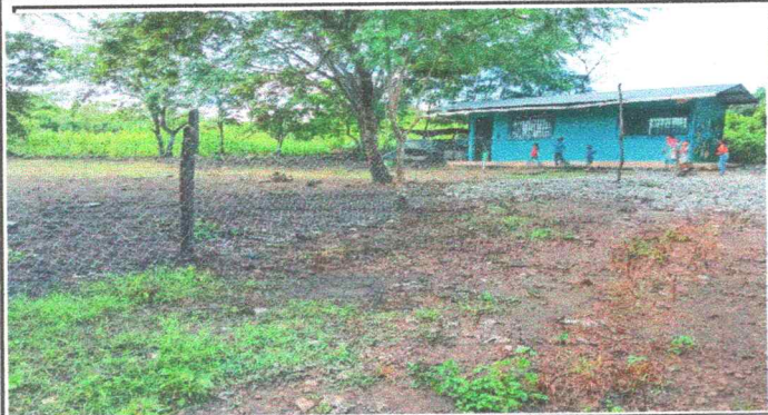
Foto 1: Reparación de muro perimetral
