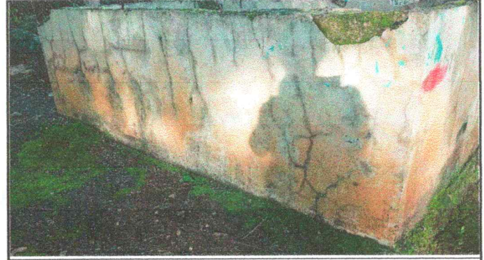
Foto 16: Reparación de sisterna de concreto
