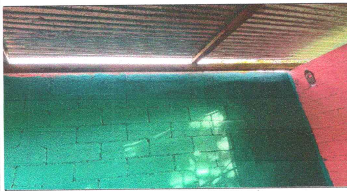
Foto 5: Sustitución de estructura de madera por metal
