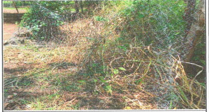
Foto 2: Reparación de muro perimetral
