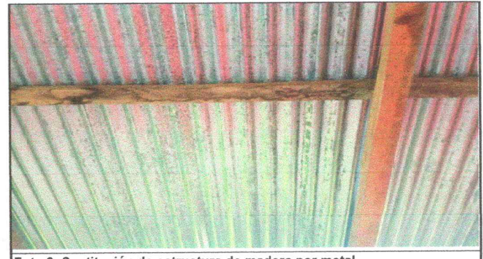
Foto 6: Sustitución de estructura de madera por metal
