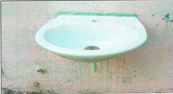
Foto 13: Sustitución de lavamanos
