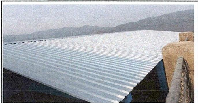
Foto 5: Sustrucción de lámina, por lámina troquelada calibre 26
