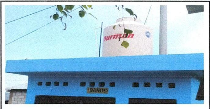
Foto 6: Sustrucción de depósito de almacenamiento de agua de 1,100 litros
