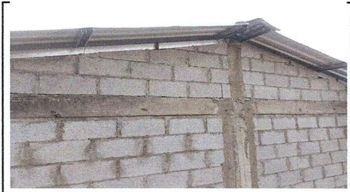
Foto 3: Mejoramiento de pared de block para colocación de estructura de soporte y lamina
