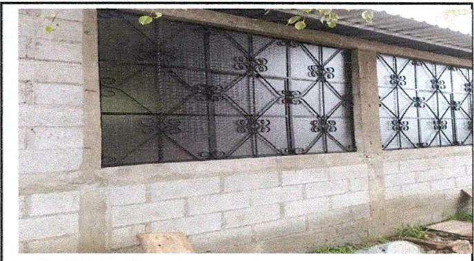
Foto 2: Sustrucción de ventana por ventana metálica
