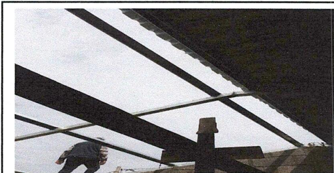
Foto 1: Sustitución de estructura de soporte de madera por metal
