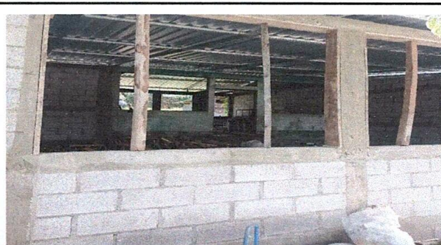
Foto 2: Sustitución de ventana por ventana metálica
