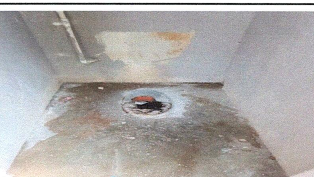
Foto 4: Sustitución de inodoros más accesorios en tanque
