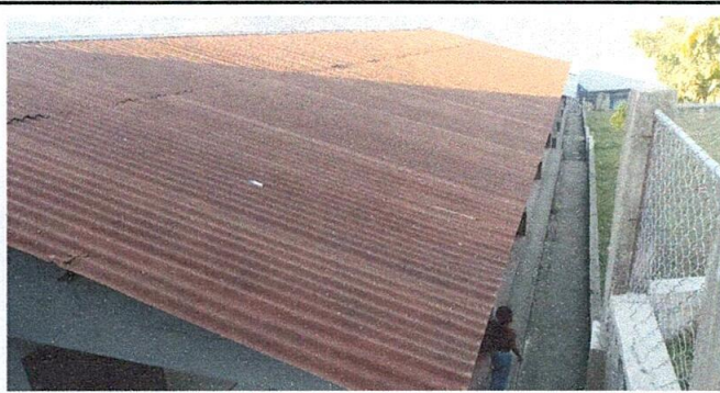
Foto 5: Sustitución de lámina, por lámina troquelada calibre 26
