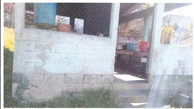
Foto 2: Sustitución de ventana por ventana metálica
