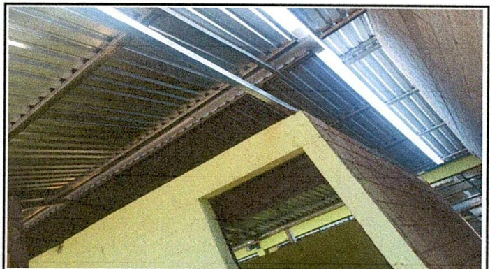
foto 4: cambio de techo de aulas
