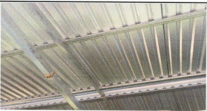
foto 5: cambio de techo de aulas
