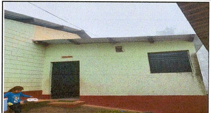
foto 2: cambio de techo de la oficina de la dirección
