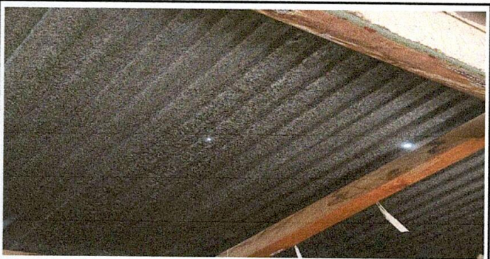
foto 5: cambio de techo de aulas
