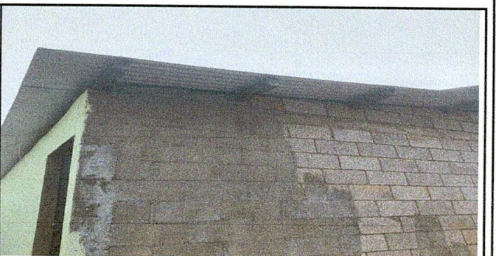
foto 6: cambio de techo de la oficina de la dirección
