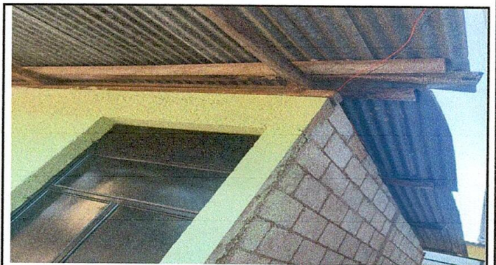
foto 4: cambio de techo de aulas
