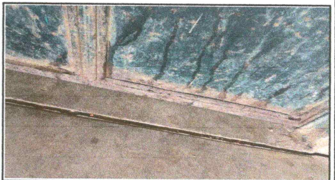
Foto 4: Reparación de puertas
