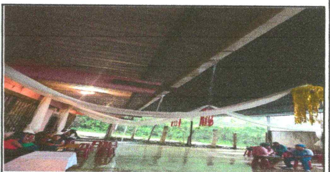
Foto 6: Reparación de canales
