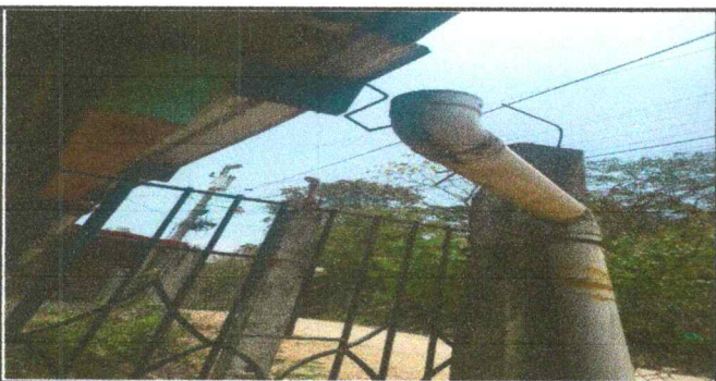
Foto 5: Reparación de canales
