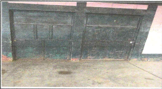
Foto 3: Reparación de Puertas
