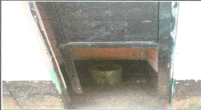
Foto1: Reparación de Baños
