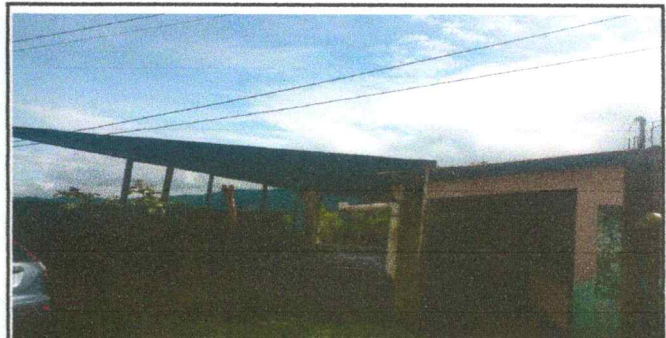
Foto 6: Reparación de estructura de techo
