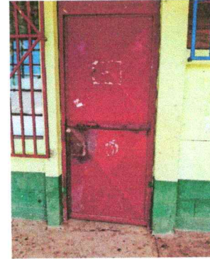
Foto 14: REMODELACIÓN DE PUERTAS
