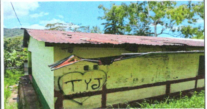
Foto 8: CUBUERTA DE LAMINA PARA UN AULA Y DIRECCIÓN
