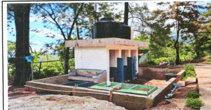
Foto 5: CUBIERTA DE LAMINA PARA BAÑOS
