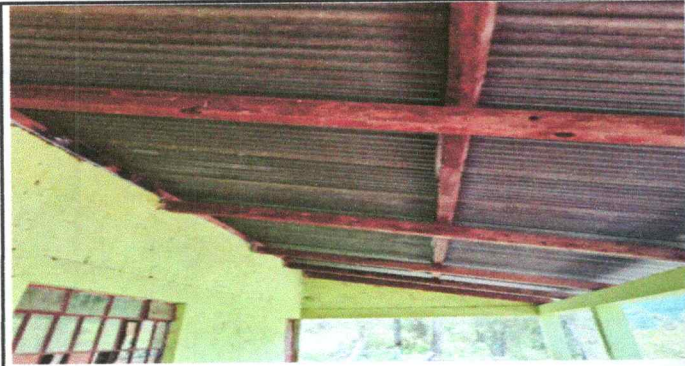
Foto 7: CUBUERTA DE LAMINA PARA UN AULA Y DIRECCIÓN
