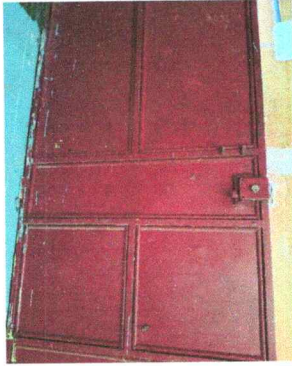
Foto 13: REMODELACIÓN DE PUERTAS
