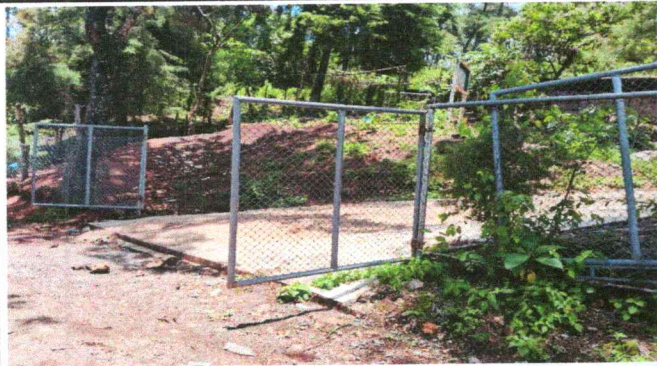
Foto 15 : REPARACIÓN DEL PORTÓN
