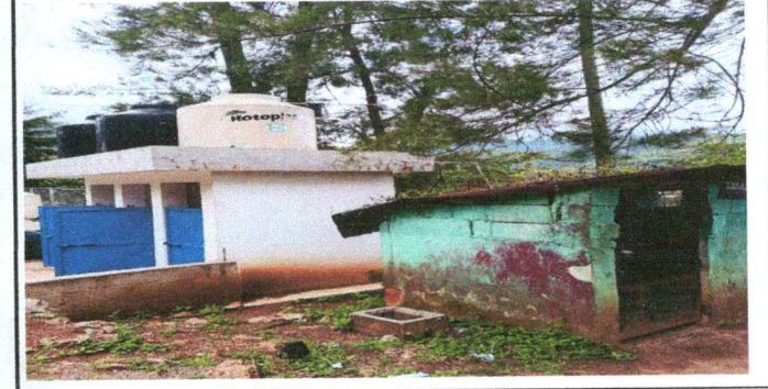
Foto 6: CUBIERTA DE LAMINA PARA BAÑOS
