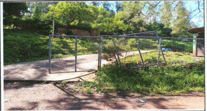
Foto 16: REPARACIÓN DEL PORTÓN
