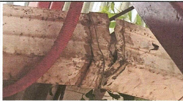
Foto 3: Sustitución de canal de PVC
