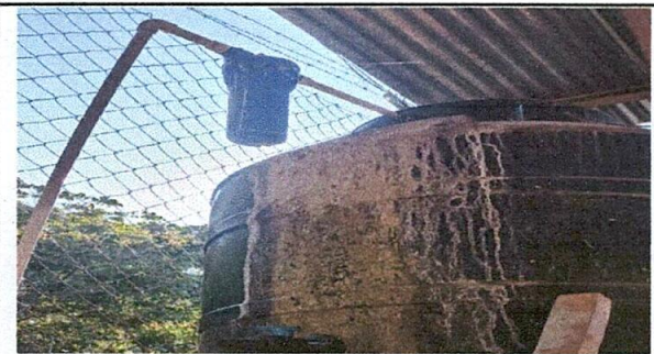
Foto 5: Sustitución de accesorios depósito de agua
