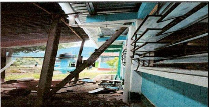
Foto 6: Bajada de agua pluvial, tubo PVC 3"
