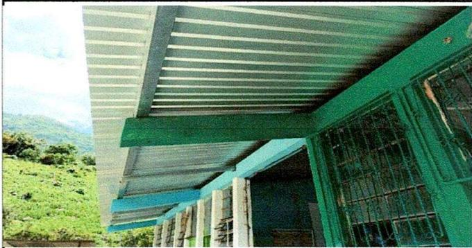
Foto1: Lámina por lámina troquelada aluzinc calibre 26
