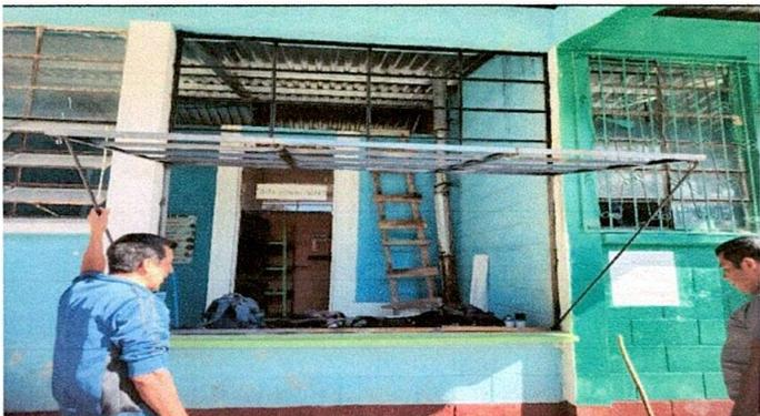
Foto 3: Cambio de estructura de metal de ventana
