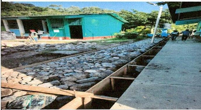
Foto7: Reparación de cuneta de concreto
